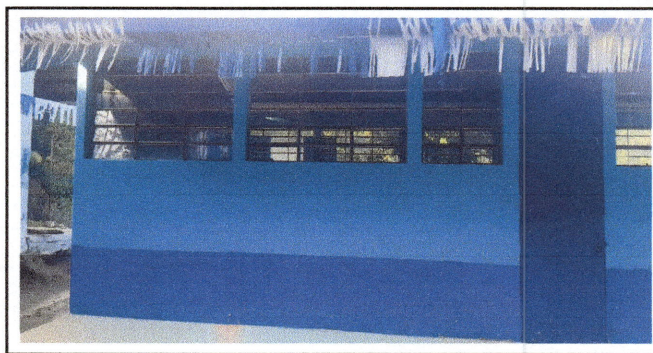
Foto 6: Vidrios sustituidos módulo 1
