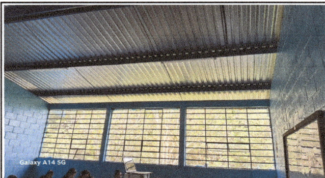
Foto 7: Vidrios sustituidos del módulo 2
