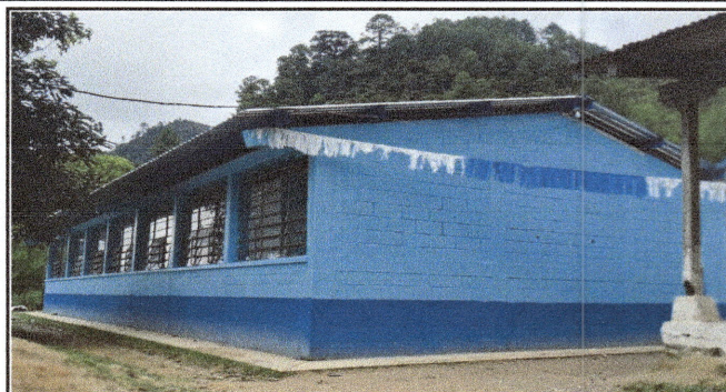
Foto 2: Estructura de techo (costaneras) con mantenimiento realizado y techo nuevo (láminas) instalado y pintura nueva aplicada en paredes interiores y exteriores del módulo 2
