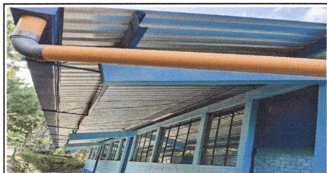
Foto 3: Canal pluvial y bajada de agua instalado
