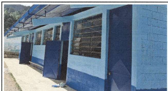
Foto 4: Mantenimiento realizado a puertas del módulo 1
