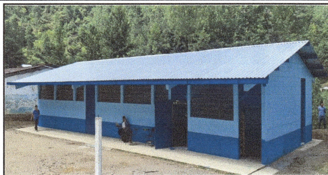
Foto 1: Estructura de techo (costaneras) con mantenimiento realizado y techo nuevo (láminas) instalado
