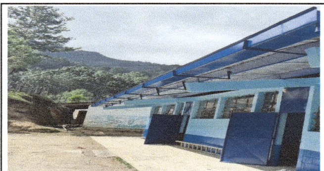
Foto 11: Canal pluvial instalado en módulo 1
